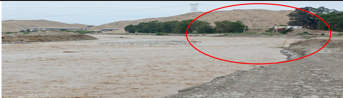
Imagen N° 1. Tramo del dique que ha sido erosionado y esta a punto de colapsar, en la margen derecha del río Chico. Se observa la magnitud de la erosión del dique y los bancos de material formados.
